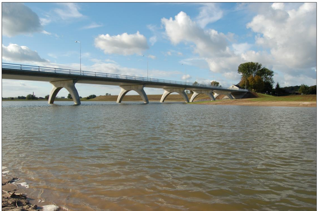
Figuur 2.1 Betonconstructie in het landschap
