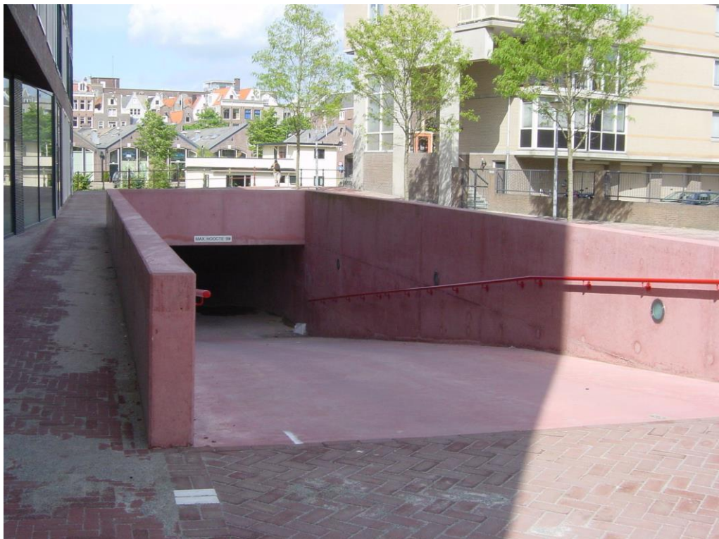
Figuur 2.15 Gekleurd beton.
