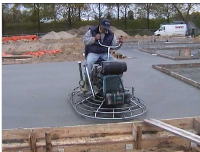
Figuur 2.7 Afwerking van een betonvloer: belangrijk!
